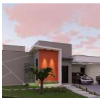
CONDOMÍNIO RESERVA DA MATA MONTE MOR
